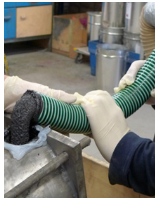
Verfüllvorgang der Gießmasse.
